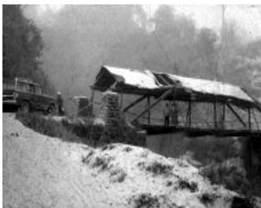
Fig. 28. En regiones más cercanas al centro eruptivo, aparte de la ceniza volcánica, los fragmentos de mayor tamaño pueden producir perforaciones y severos daños a los techos, y a las vías de comunicación. Estas fotos muestran ese tipo de daños producidos por las erupciones del volcán El Chichón en 1982, dentro de un radio de 10 km. Arriba, foto de un techo perforado por líticos. A la derecha un puente semidestruido por impactos de líticos. Fotos de S. De la Cruz.
